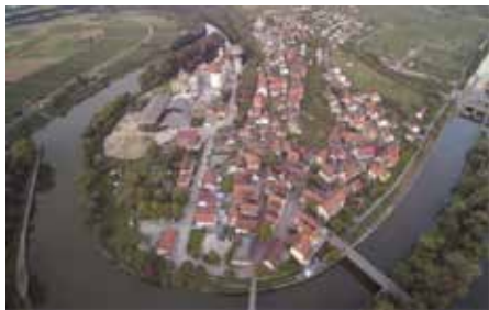
Sanierung Lauffen V Städtle
