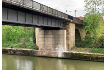
Kanalbrücke (Alte Neckarbrücke)
