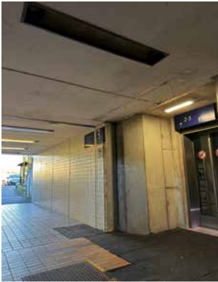
Die Aufzüge am Lauffener Bahnhof bieten seit 2022 Erleichterungen für Reisende
