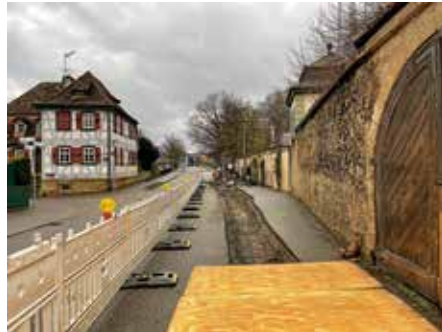
Bauarbeiten für den Fußgängerüberweg in der Nordheimer Straße
