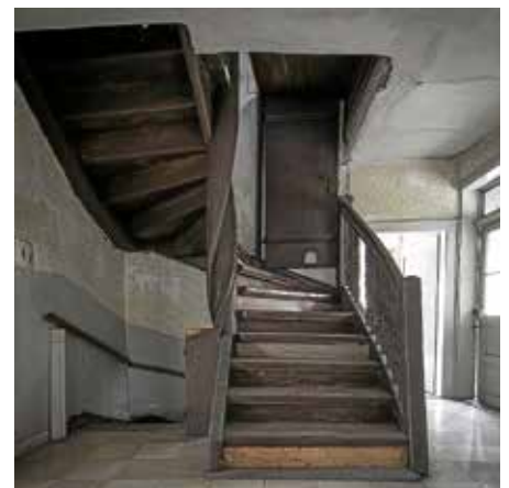
Die große Treppe des Hölderlinhauses vor der Sanierung (Foto: Brändle)
