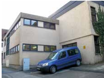
Ein städtisches Projekt soll die energetische Sanierung des Kindergartens im Städtle sein.
