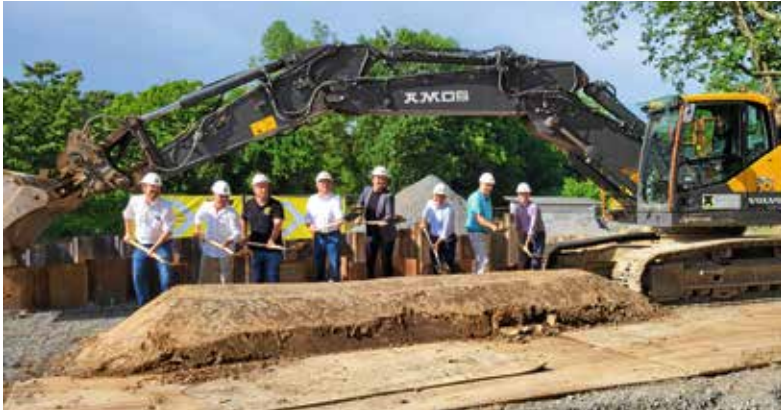
Symbolischer Spatenstich durch Bürgermeister Waldenberger und die Projektbeteiligten.
