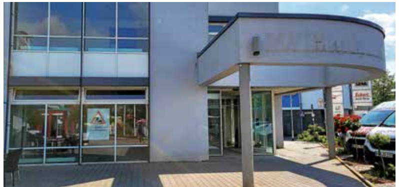
Hier entstehen gerade die neuen Räumlichkeiten des Bürgerbüros, die im Rahmen eines „Tags der offenen Tür“ am 29. Juli der Bevölkerung vorgestellt werden. (Foto: Bettina Keßler)
