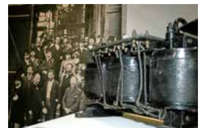
Altes Foto der Drehstromübertragung Lauffen – Frankfurt vor über 100 Jahren
