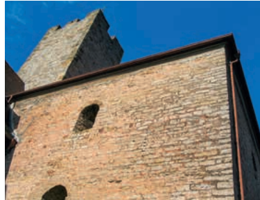
der Rathaussturm in Richtung Himmel fotografiert
