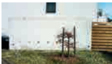
Schlehenweg 14: Abgesägte Äste im Schlehenweg.
