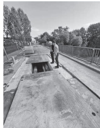
Aufsichtsratsvorsitzender Klaus-Peter Waldenberger und Geschäftsführer der Stadtwerke Lauffen a.N. GmbH, Frieder Schuh machten sich am Montag ein Bild von der Baustelle.
