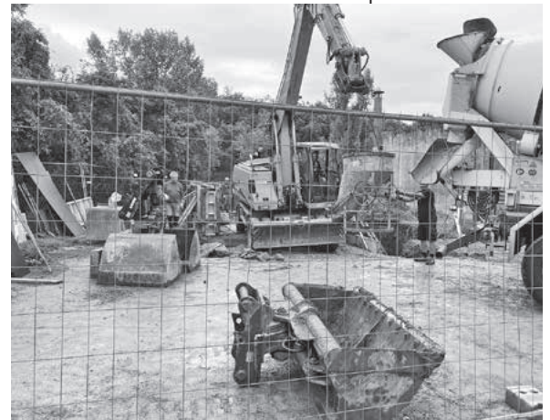
Betonage der Kehrbox durch Fa. Walter Schmidt GmbH, Freiberg
