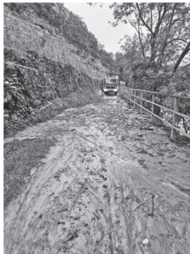
Starkregen am 17. Juni 2020 am Neckartalradweg mit starken Schlammablagerungen
