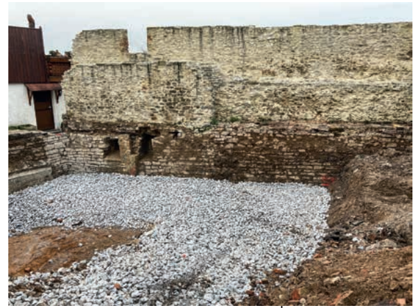
Der obere Mauerteil wurde bereits saniert. Links der Übergang zur westlichen Stadtmauer.
