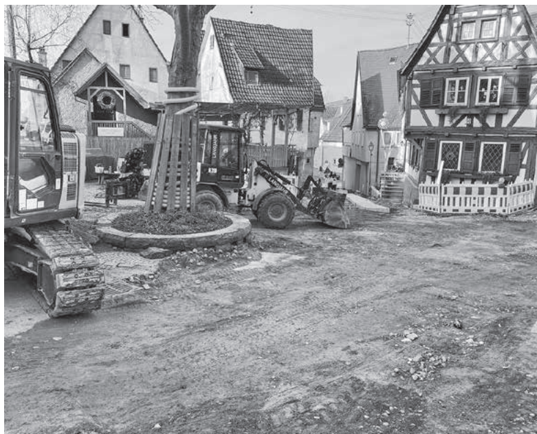
Kaum wieder zu erkennen ist wegen der Bauarbeiten zur Zeit das Sonnenplätzle im Städtle.
