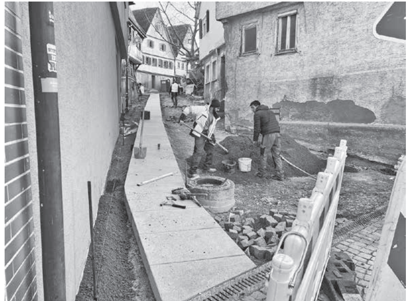
Ein in das Pflaster integrierter Plattenstreifen dient der Barrierefreiheit.
