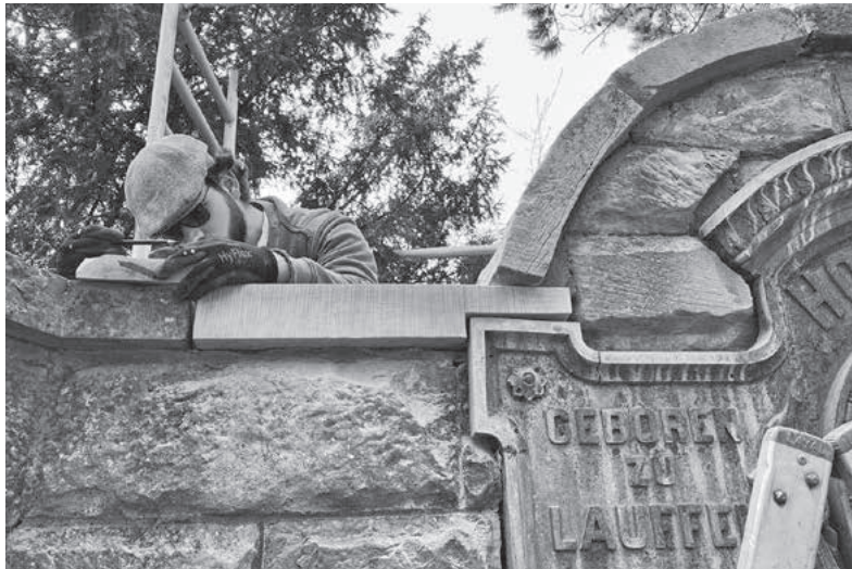
Sorgfältig wird die neue Abdeckplatte eingepasst.
