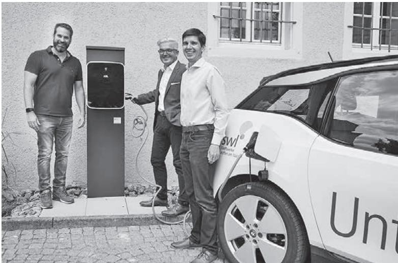
Nehmen die neue E-Ladesäule vor dem Lauffener Rathaus in Betrieb: (v. l.) Lars Ehrenfeld, ZEAG-Projektleiter Ladeinfrastruktur; Bürgermeister Klaus-Peter Waldenberger; Frieder Schuh, Geschäftsführer der Stadtwerke Lauffen.
