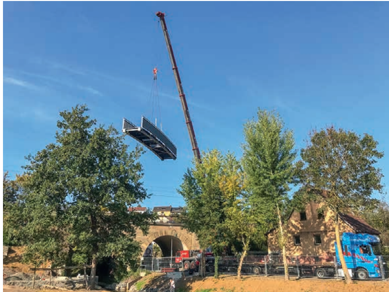
Ein nicht alltäglicher Anblick: mit einem Autokran wird die 6 Tonnen schwere Brücke eingehoben.
