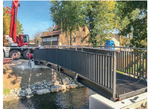
Passt genau – die Brücke sitzt fest in den Widerlagern.
