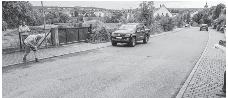
Markierungsarbeiten auf Höhe Einmündung Hohe Straße/B27
