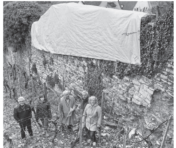
Sanierung Schenkelmauer (Foto: Riecker)
