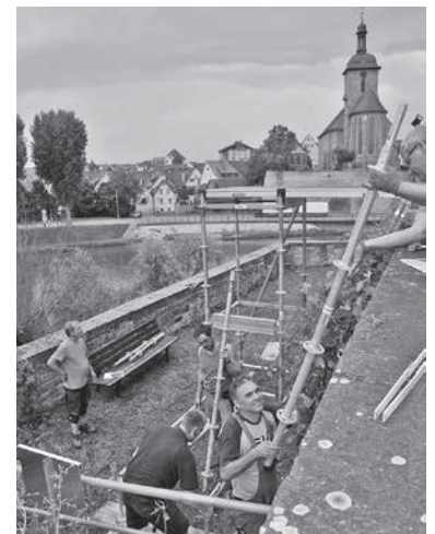
Hier wird gerade die Bühne für „Wein auf der Insel“ aufgebaut.
