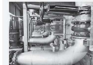
Optimierung Tropfkörperpumpwerk (Maßnahmenblock 3)
