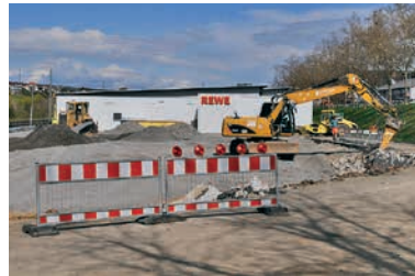
Nun geht es los – die Bauarbeiten hinter dem REWE-Markt haben begonnen.
