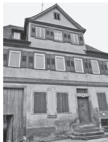
Eines der Themen bei der Bürgerversammlung: Das Hölderlin-Haus.
