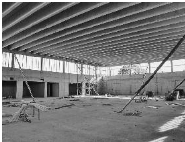
Die Sporthalle im Rohbauzustand
