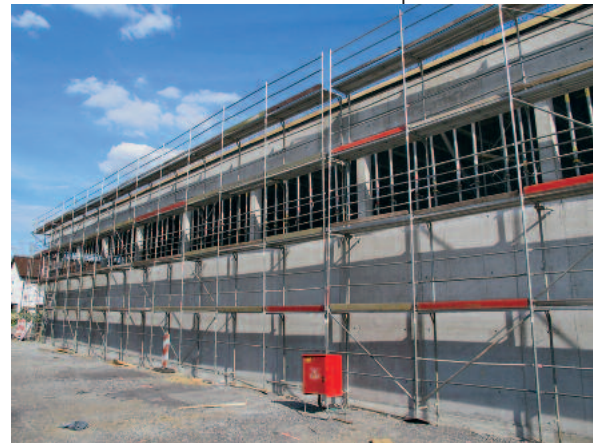
Der Rohbau der Sporthalle ist nahezu abgeschlossen
