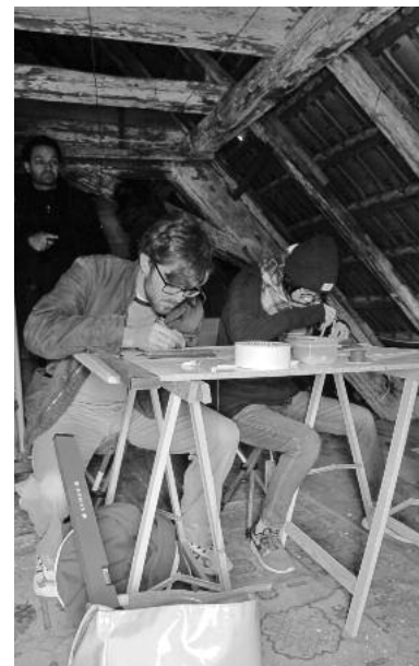
Zeichnerische Bestandsaufnahme des Dachstuhls
