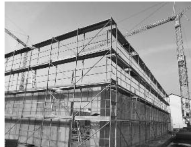
Aktueller Baustand Sporthalle
