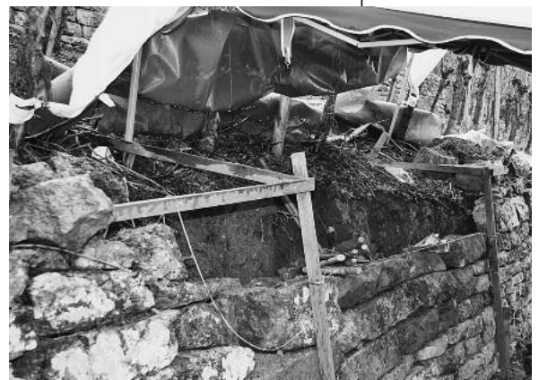
Bau einer Trockenmauer
