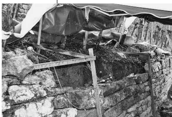
Instandsetzung einer Trockenmauer im Rahmen des Landschaftspflegertages 2014
