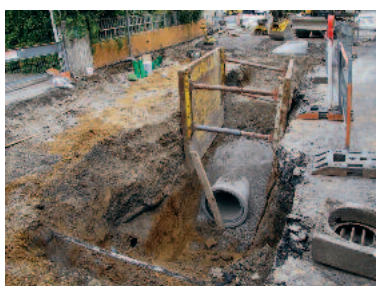
Kanalarbeiten in der Neckarstraße
