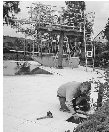
Erneuerung/Ausbesserung der Plattenbeläge im Freibad
